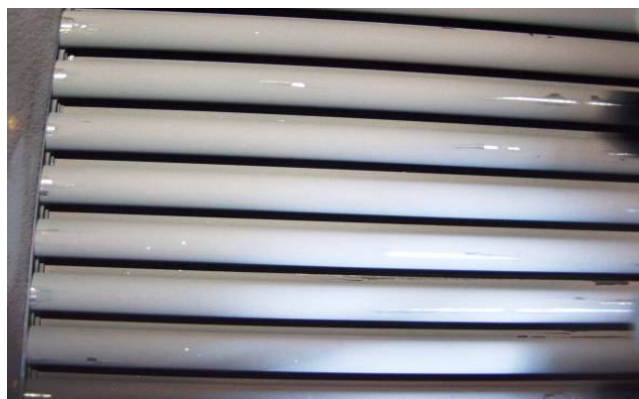
Рисунок 8. Состояние теплообменных трубок ПГВ-1000М энергоблока № 4 РАЭС (введен в эксплуатацию в 2004 году, химическая отмывка не проводилась)
