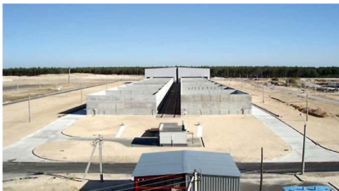
Рис. 2. Приклад будівлі приповерхневого сховища
