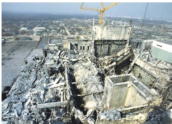
Рис. 1. Завали будівельних конструкцій у зруйнованому 4-му блоці Чорнобильської АЕС
