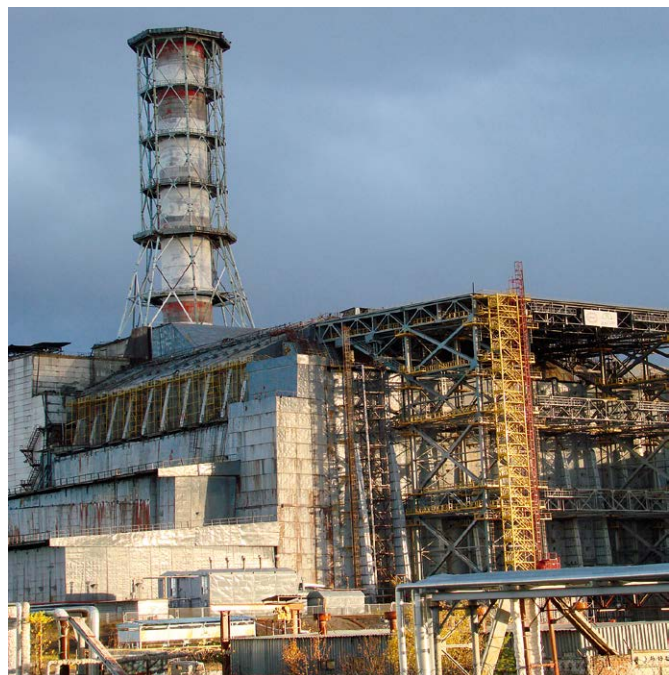
Рис. 5. Загальний вигляд засобів шляхів доступу (сходові клітки і підйомник по осі С, 55) у район північних щитів-«ключок» із західного боку об'єкта «Укриття»
