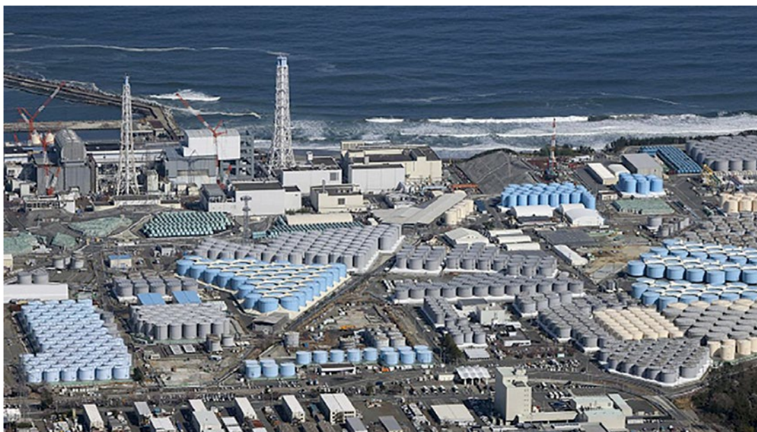
Рис. 1. Резервуари для зберігання радіоактивно забрудненої води на АЕС «Фукусіма-Даїчі» [4]
